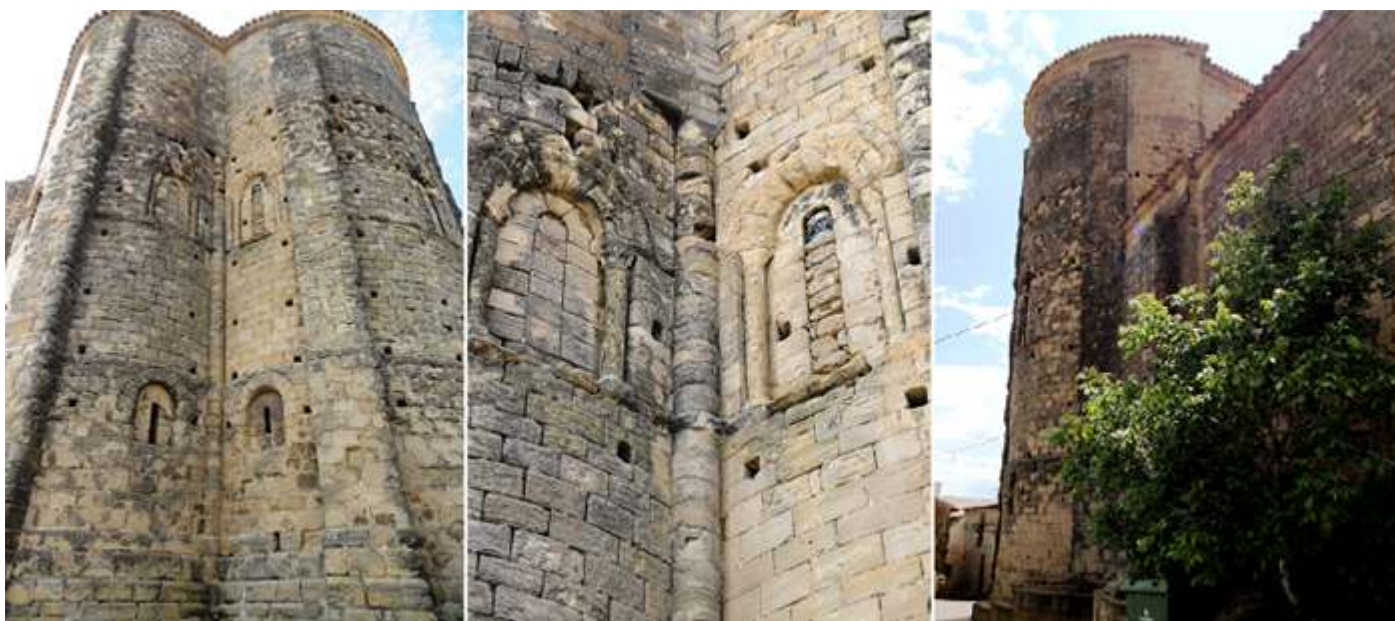
❶ Los gruesos contrafuertes, llegan casi hasta el alero que es liso sin canecillos. ❷ Otras dos ventanas cegadas. ❸ Y el tercer ábside, dando este a la calle que nos lleva a la ermita de Nuestra Señora de Puyal.
