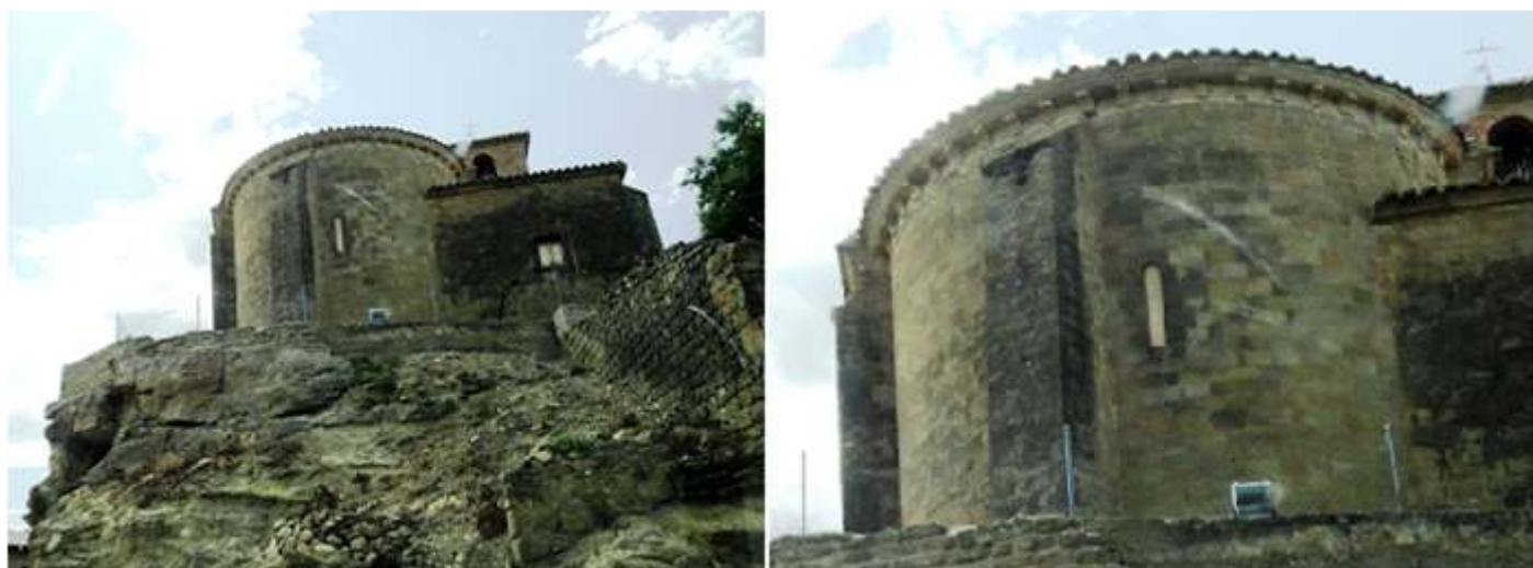
❶ Sobre un inmenso peñasco se levanta el templo. ❷ Su ábside semicircular con un alero con canecillos lisos y está abierto por una ventana saetera, junto con robustos contrafuertes.
