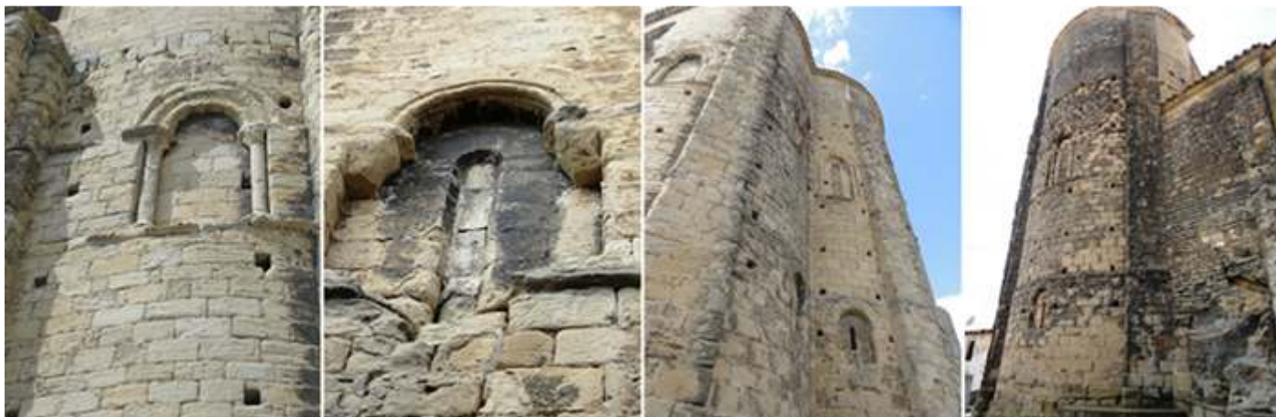
❶ Ventana cegada con una archivolte del ábside de la Epístola ❷ Detalle de una de las ventanas que ha perdido sus columnillas y parte del antepecho por la erosión de la piedra. ❸ El conjunto de la cabecera llama la atención su considerable altura. ❹ Detalle del cilindro absidal del Evangelio y la construcción anexa del S. XVI.
