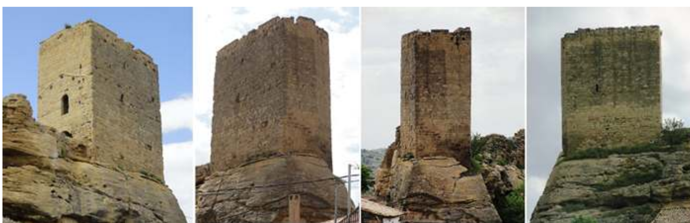
1 x. 2 m. 3 m. 4 Para aumentar su aspecto inexpugnable su puerta se situaba en alto y se accedía por escalera portátil. Dispone de dos entradas orientadas al oeste fruto de la reforma del S. XVI (de medio punto, soterrada) y encima la original. 5 su torre pentagonal esta en el lado noreste del cerro
