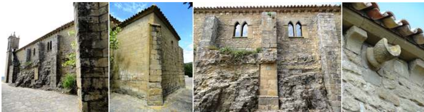
❶ Lateral epistolar desde la sacristía. ❷ Exterior de la sacristía. ❸ En este lado epistolar y entre sus contrafuertes una dobles ventanas de arco apuntado. ❹ Detalle de los canecillos lisos abocelados y una gárgola.
